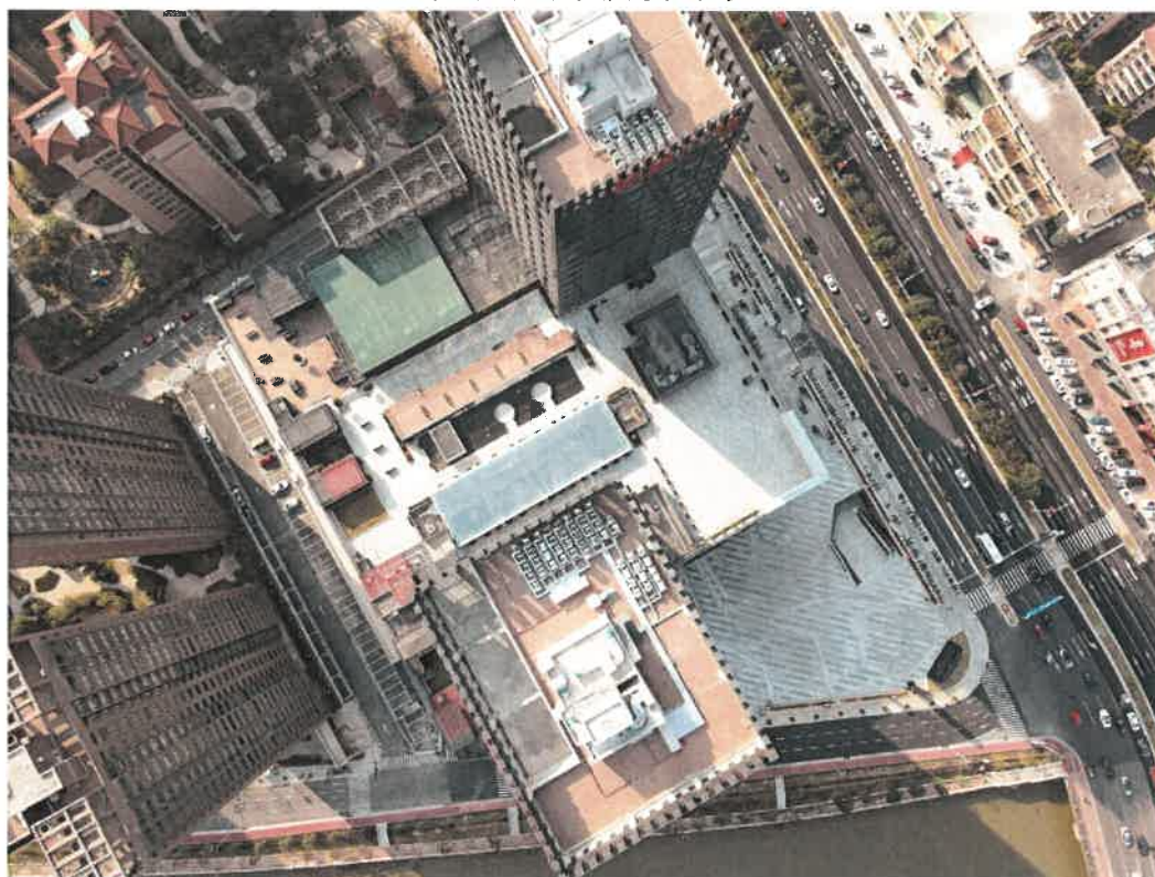
项目区建筑物现状
