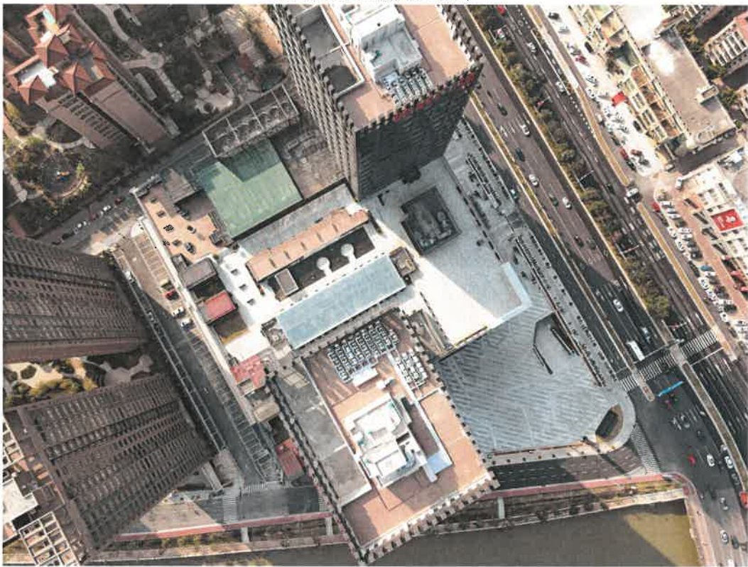
项目区建筑物现状
